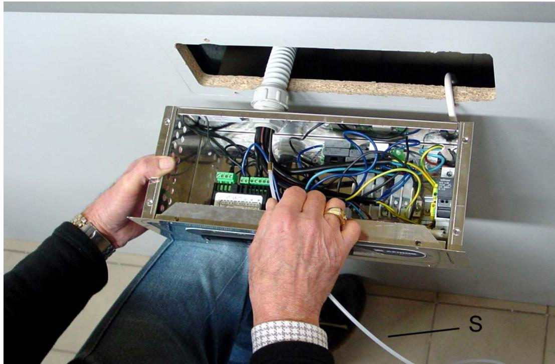
De sonde zal in de technisch ruimte uitkomen en moet dan ingebracht worden in het gat van de verwarmd rumite dat bestemd is voor de passage van de elektrische kabels.
