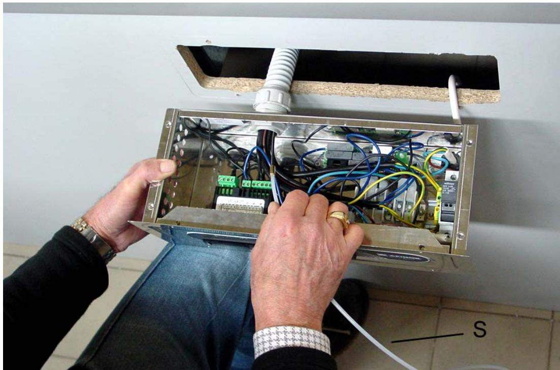
Зонд выйдет со стороны технической ниши, после чего его надо вставить в отверстие для электрошнуров ниши с подогревом.
