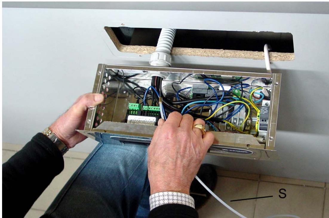
Le tire-fil sortira dans le compartiment technique; ensuite, il devra être inséré dans le trou du compartiment chauffé prévu pour le passage câbles électriques.
