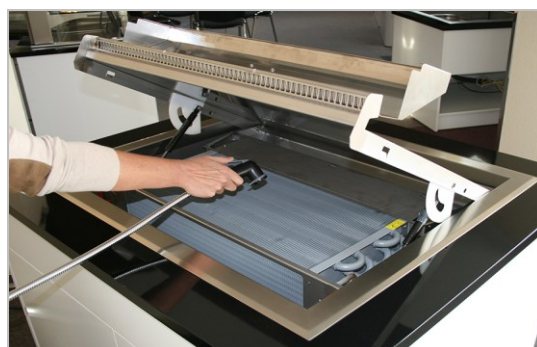
Abb. 6.11 Verdampfer mit Brause (oder weicher Bürste) reinigen.
