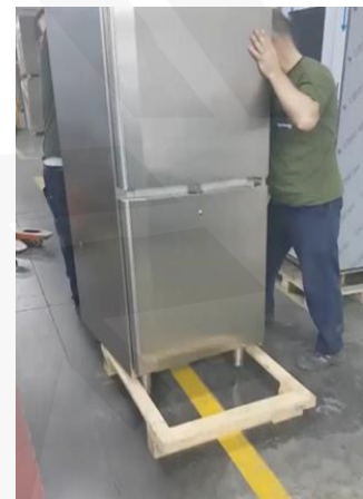
Abb. 10-11-12: Mit Hilfe eines Hubwagens oder durch äußerst vorsichtiges einseitiges Anheben bzw. Kanten des Gerätes - Achtung: kopflastig! - kann die Palette nun unter dem Gerät herausgezogen werden. Hierzu nicht zwischen Gerät und Palette oder unter die Palette fassen Quetschgefahr!
