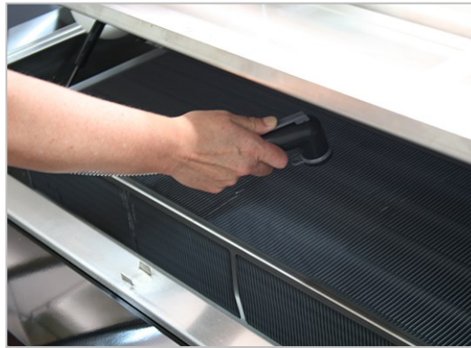
Abb. 6.11 Verdampfer mit Brause oder weicher Bürste reinigen.
