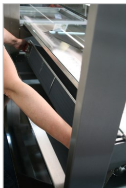
Abb. 6.10 Verdampfer aushaken und auf dem Wannenboden ablegen.
